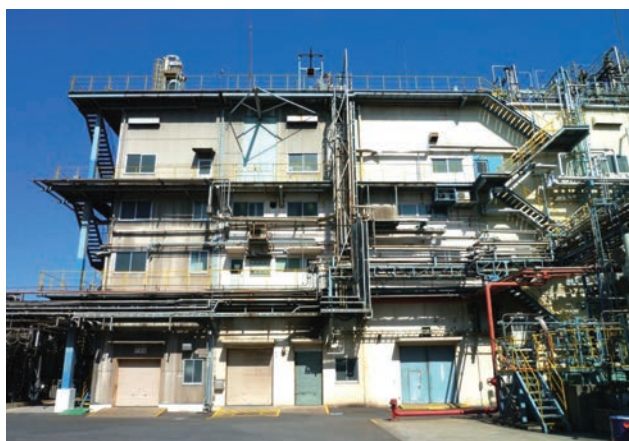
図2 MMP製造プラント(生産能力800t)
